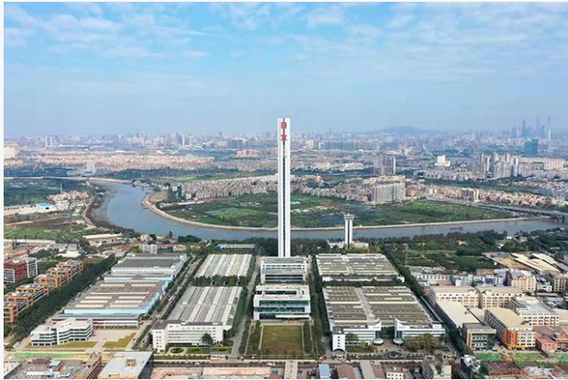
“H1 TOWER”电梯试验塔
